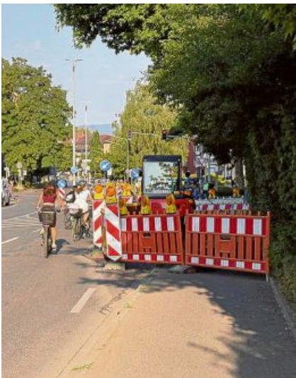
Die Technischen Betriebe bauen an der Ostseite des Zähringerplatzes einen sicheren Übergang vom (vorübergehend gesperrten) Radweg auf die Straße. FOTO: JÖRG-PETER RAU
